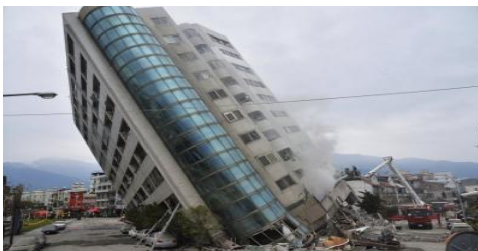
Рисунок 3.1.2 - Пример прогрессирующего обрушения
