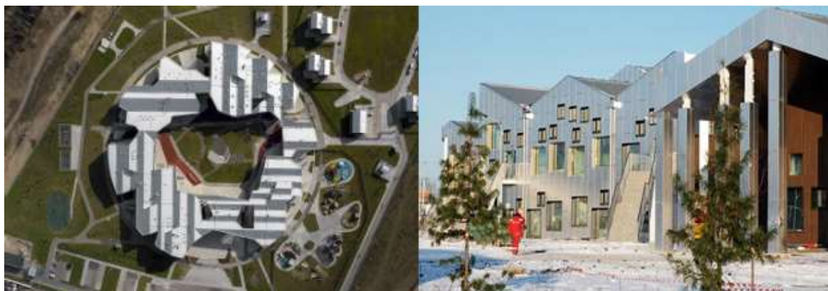
Рисунок 1 – Комплекс «Точка будущего»
